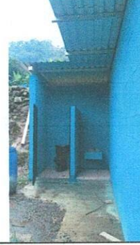
Foto 2: Baño y lavamanos instalados
