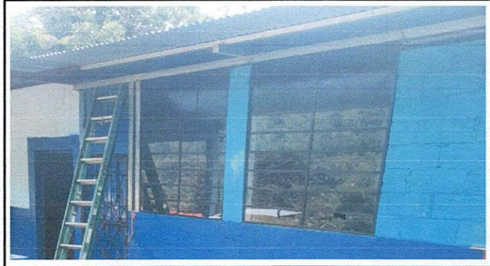
Foto 2: ventanas de metal Instaladas
