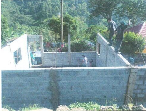
Foto 1: Paredes del módulo completado
