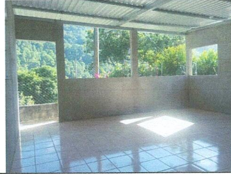
Foto 4: Colocacion de piso cerámico finalizado
