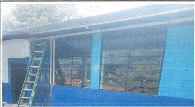
Foto 3: ventanas de metal Instaladas
