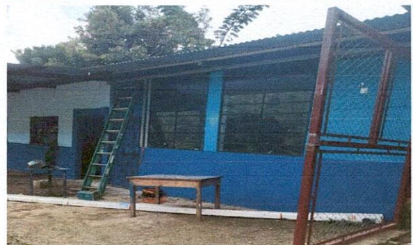
Foto 4: ventanas de metal Instaladas
