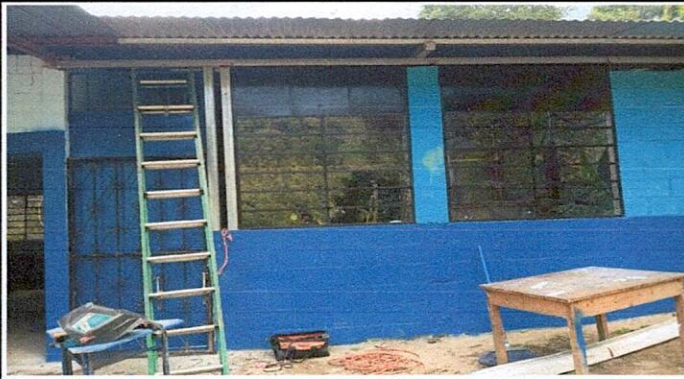
Foto1: ventanas de metal Instaladas
